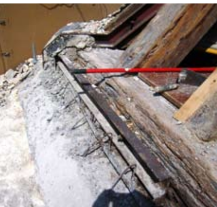
A la izquierda, vista del durmiente de cubierta antes de la intervención. En el centro, proceso de ejecución del refuerzo de coronación del muro y alero de la cornisa terminado (derecha).
