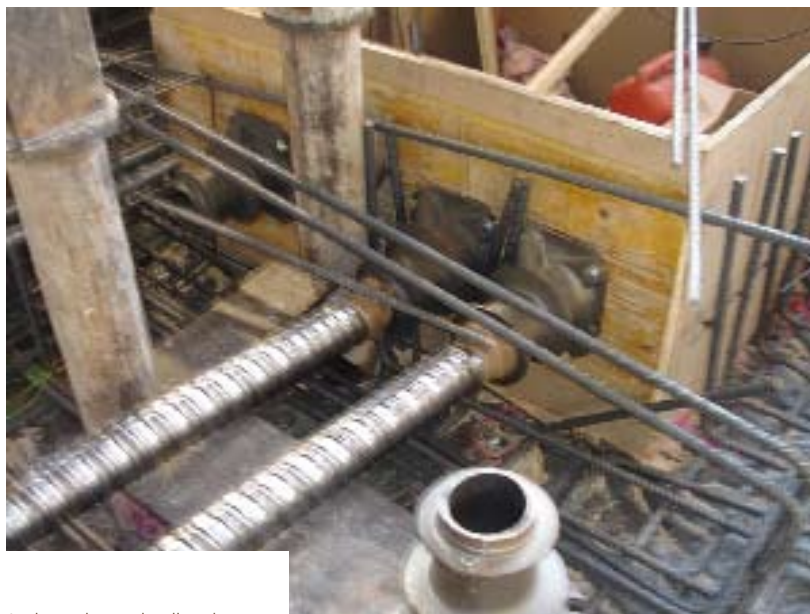
Arriba y abajo, detalles de cajones y vainas de armaduras postesadas.
