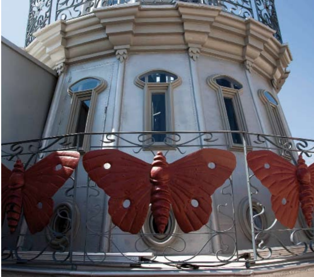
Arriba, detalle de barandilla de la linterna. A la izquierda, planta ático y linterna ya restaurada. A la derecha, detalle de barandilla de escalera antes de su restauración.
