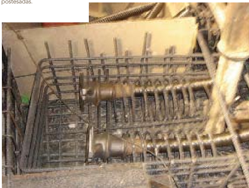
Arriba y abajo, detalles de cajones y vainas de armaduras postesadas.
