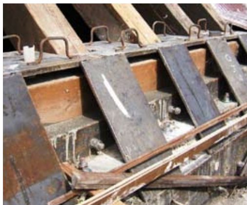
A la izquierda, vista del durmiente de cubierta antes de la intervención. En el centro, proceso de ejecución del refuerzo de coronación del muro y alero de la cornisa terminado (derecha).
