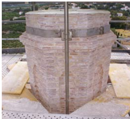
Vista lateral de la corona terminada.
