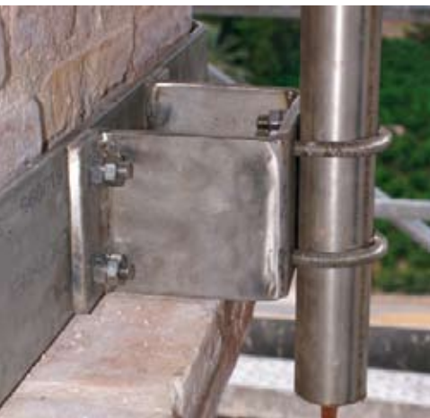
Anclaje del mástil del pararrayos y zuncho de pletina.
