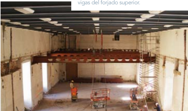
Las vigas se introducían en el edificio por las ventanas de los patios y para su montaje se colgaban de trácteles anclados a las vigas del forjado superior.
