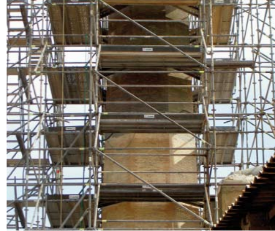
Limpieza con chorro de arena.
