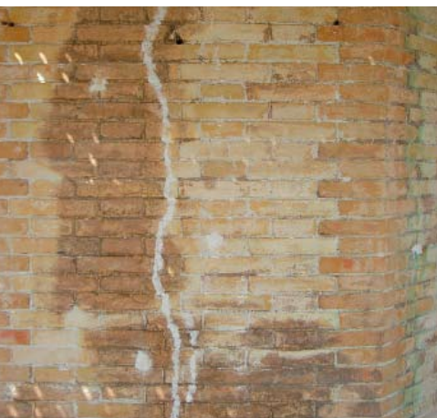
Vista lateral de la chimenea.
