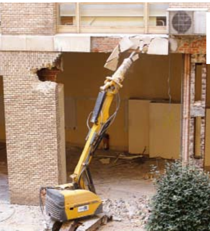
Izquierda, demoliciones de fachada de patio. Derecha, saneo del tablero de uno de los forjados existentes compuesto por estructura metálica y bovedillas cerámicas.
