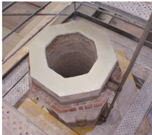
Corona con mortero de protección perimetral en albardilla.
