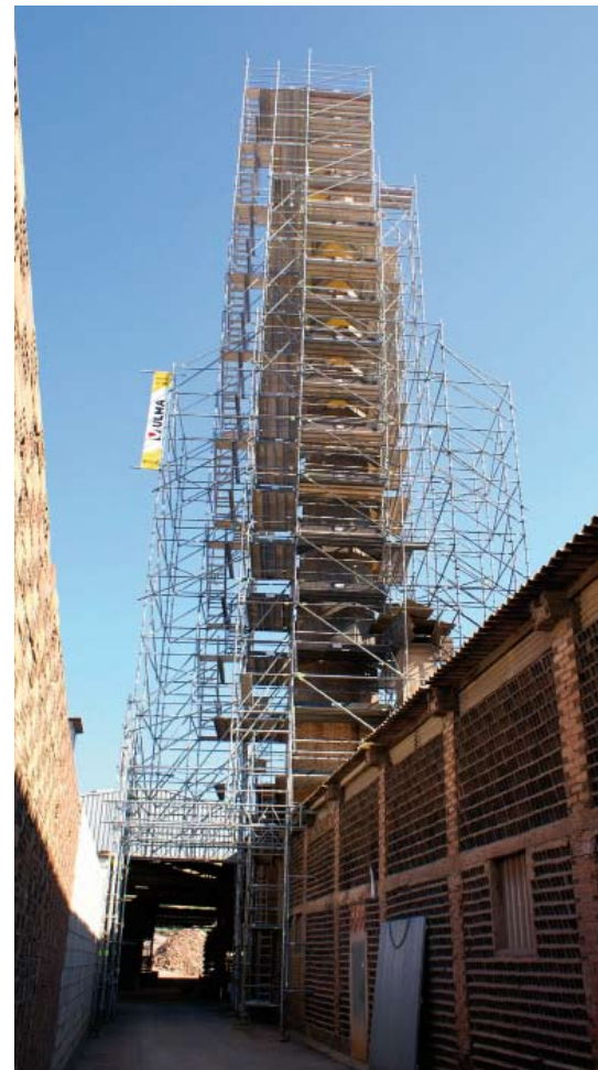
Vista general del andamio.
