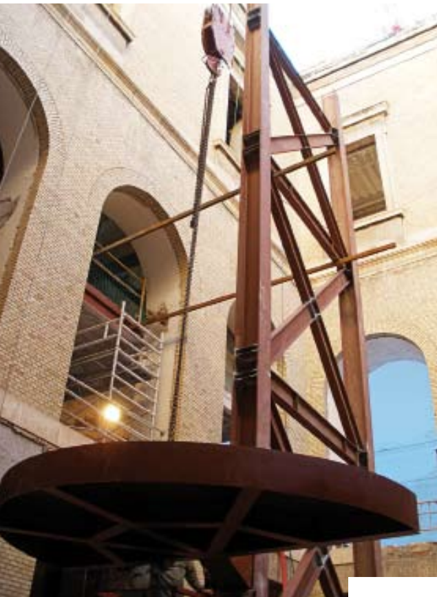
Montaje de la estructura metálica de las escaleras principales en los patios.
