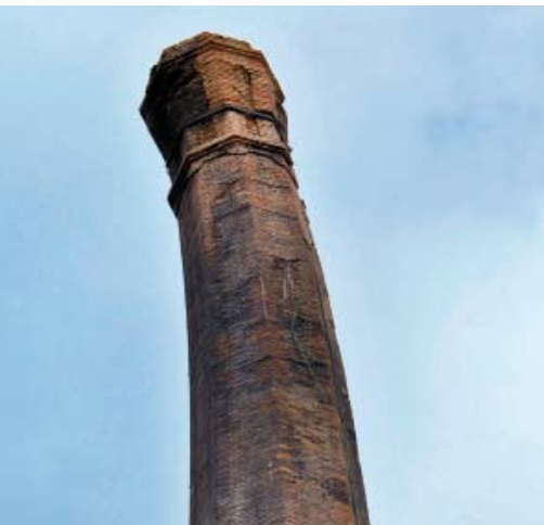
Desplome. Vista general.
