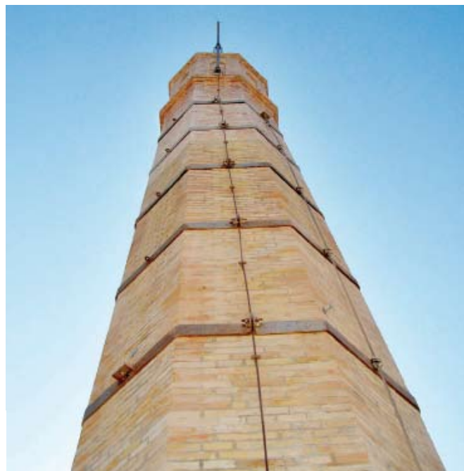
Dos imágenes que muestran el antes y después de las obras.
