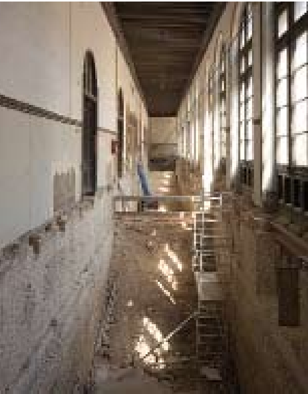
Arriba, de izquierda a derecha, excavación para el sótano en el patio claustro; vaciado del sótano bajo el edificio (sala columnas de fundición); losa de cimentación del sótano claustro y atarjeas, y vaciado del sótano bajo exedra. A la izquierda, vaciado del sótano con entramado de vigas de acero para el nuevo forjado en sala de columnas y vigas para el nuevo forjado de planta baja en la girola de exedra. A la derecha, encofrado del muro del sótano del patio claustro.
