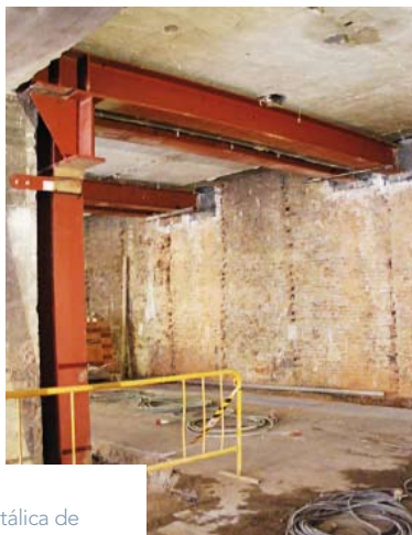
Ejecución de galería de instalaciones bajo el salón de actos.
