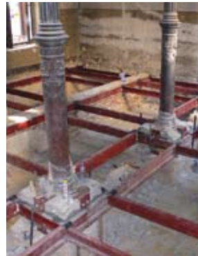
Arriba, de izquierda a derecha, excavación para el sótano en el patio claustro; vaciado del sótano bajo el edificio (sala columnas de fundición); losa de cimentación del sótano claustro y atarjeas, y vaciado del sótano bajo exedra. A la izquierda, vaciado del sótano con entramado de vigas de acero para el nuevo forjado en sala de columnas y vigas para el nuevo forjado de planta baja en la girola de exedra. A la derecha, encofrado del muro del sótano del patio claustro.
