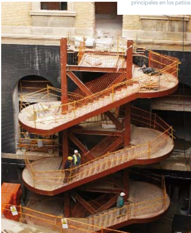
Montaje de la estructura metálica de las escaleras principales en los patios.
