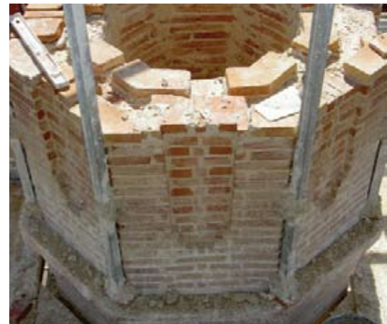
Detalle de la reconstrucción de la corona y las molduras.
