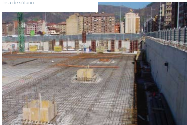
Arriba, mejora de terreno e impermeabilización de losa de cimentación con bentonita de sodio. Abajo, armado de losa de sótano.
