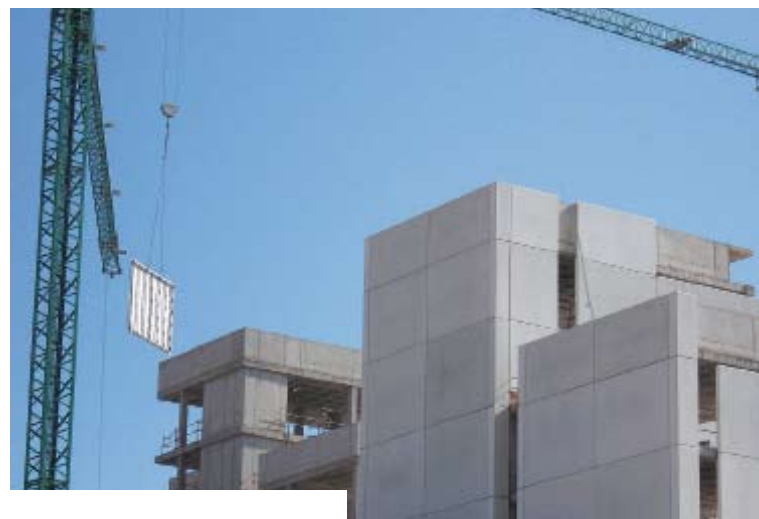
Arriba, colocación de paneles de GRC en fachadas. Abajo, vista aérea durante la construcción.
