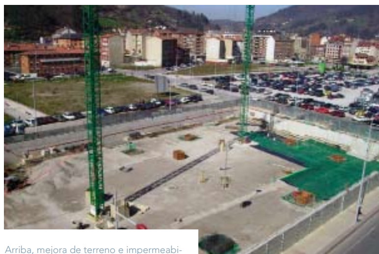
Arriba, mejora de terreno e impermeabilización de losa de cimentación con bentonita de sodio. Abajo, armado de losa de sótano.
