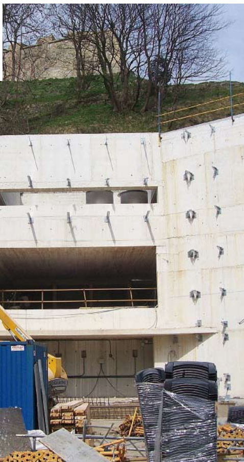
Colocación de ménsulas sobre muros de hormigón para, después, proyectar el aislamiento sobre paramentos y montaje de paneles de aluminio en la fachada.
