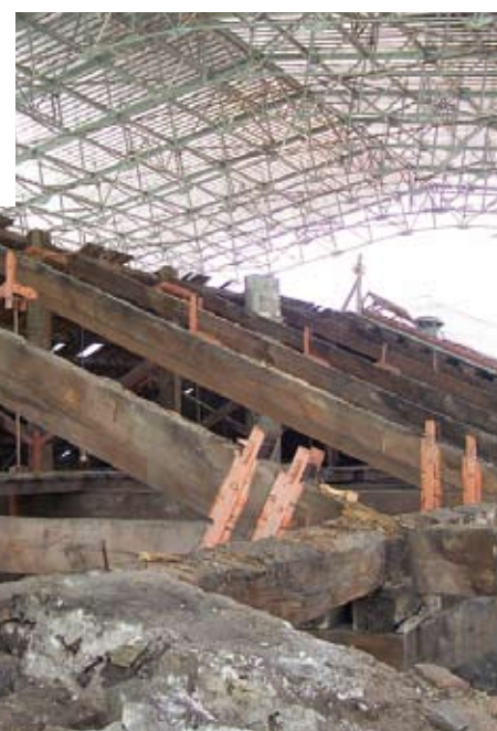
Izquierda, la fachada oeste de la iglesia con el montaje de la sobrecubierta de protección. Derecha, estructura de cerchas de madera de la iglesia a retirar bajo la sobrecubierta de protección.
