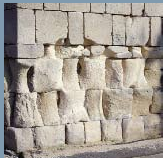
A la izquierda, imagen de la catedral de Toledo. A la derecha, pérdida de cohesión de sillares de un paramento.
