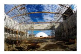
Imágenes aéreas de la evolución de los trabajos de construcción del edificio del auditorio, de volumen rotundo, cuya cubrición sólo está apoyada en la viga-muro de arriostramiento transversal.
