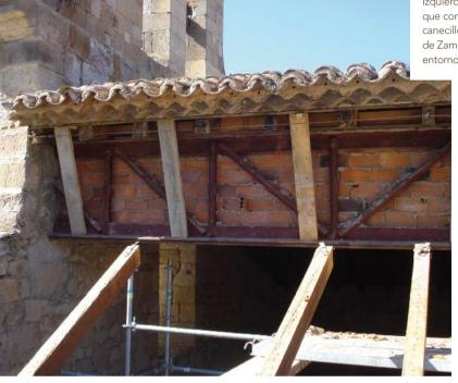
Izquierda, celosía metálica oculta tras un muro de ladrillo que conforma el tramo central de la nave. Derecha, canecillos sacados a la luz en la ermita de Los Remedios, de Zamora. En la página siguiente, vista del muro sur y su entorno una vez terminada la intervención.
