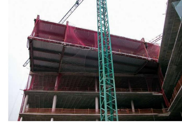
La planta cuarta tiene una superficie de unos 160 m² suspendidos en el aire y sustentados por cuatro vigas metálicas que vuelan desde la cubierta y de las que cuelga esta zona del forjado mediante cuatro tirantes de acero macizo. El vuelo en la zona más corta del voladizo es de unos cuatro metros, y en el extremo más alejado es de casi nueve metros.
