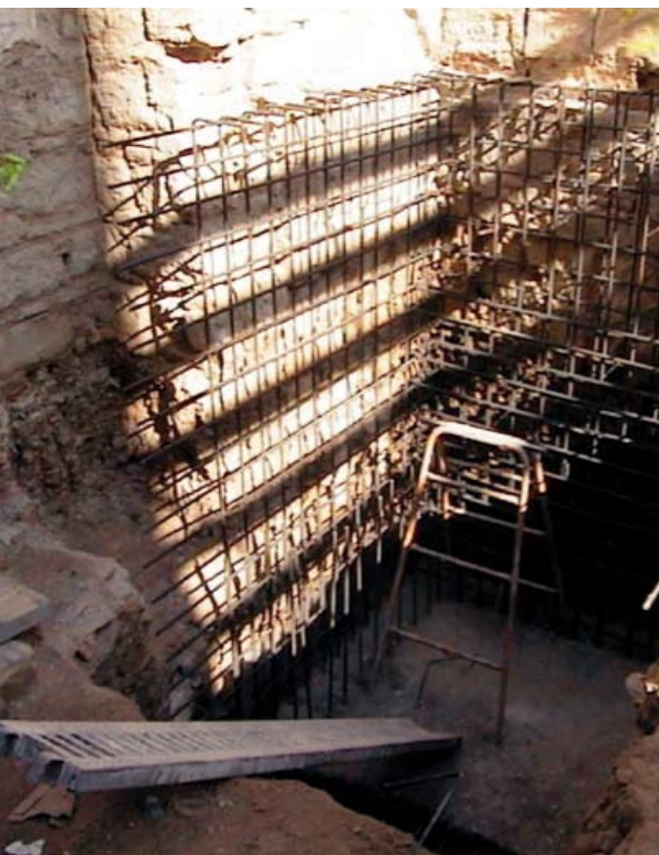
A la izquierda, batache en esquina para la ejecución de la losa de cimentación y de los muros de contención de planta sótano. A la derecha, ejecución de la nueva escalera de acceso a la planta alta, rehabilitación de nave lateral de planta baja y ejecución de aseo.
