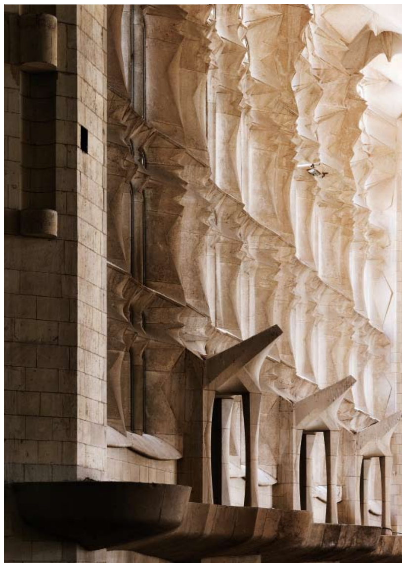
Arriba, construcción de las bóvedas del crucero. Abajo, vista interior de los ventanales de la nave lateral.
